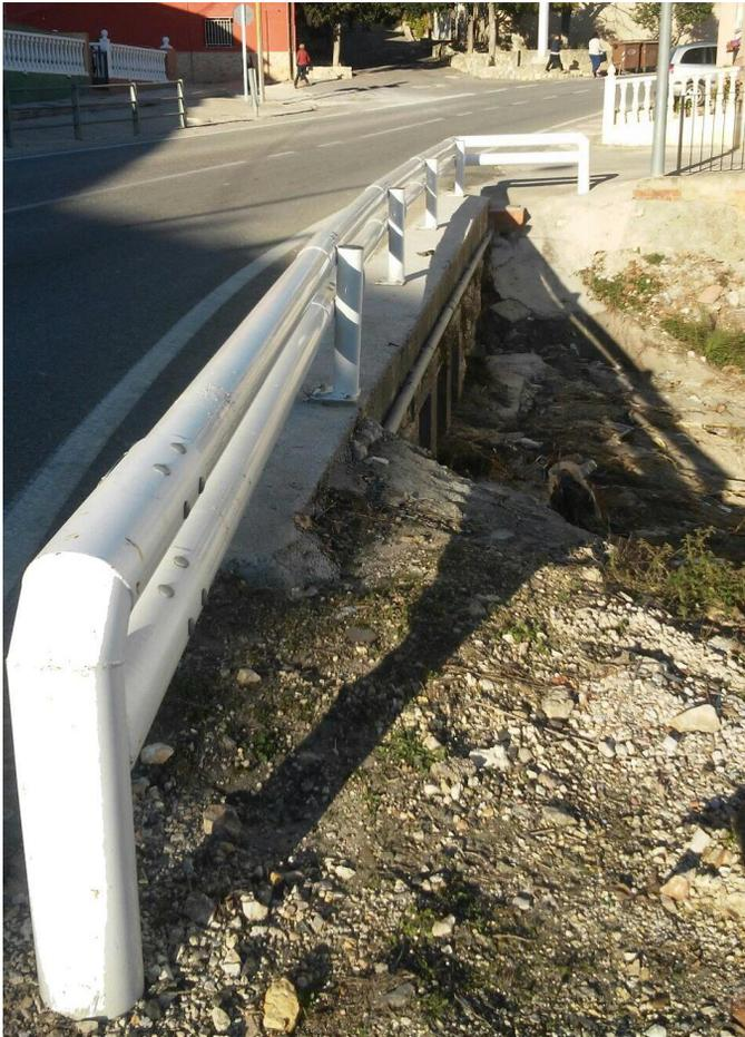
**Barrera BPC para puente con canalizaciones**
